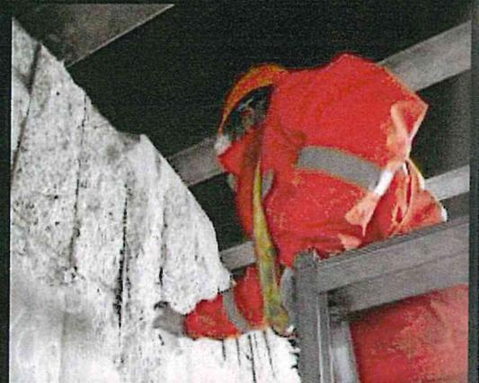
①エポキシ樹脂が含浸し、ひび割れの進行を抑制
