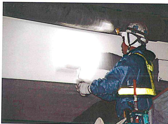
上塗り施工前の橋脚梁部／ローラーでの上塗り施工
