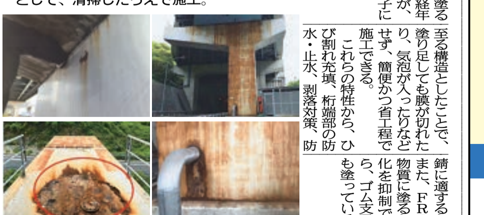
⑤【鋼製橋脚】 橋脚など局所的に減肉した個所にて、パテにて成形後に防食対策として施工。排水管路周りなどの取合い部も一括で施工が可能。
