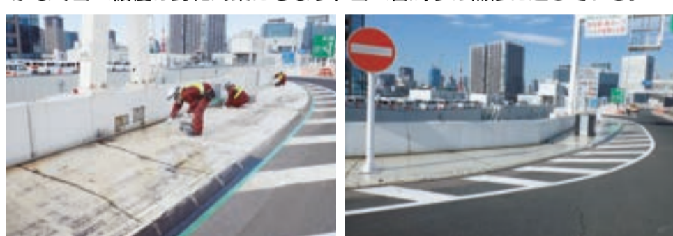
②【鋼製高欄との取合い部】 拡幅高欄上の防水対策として施工。鋼製高欄とコンクリート床版との取合い部など材質の変化点にも適用が可能であり、塗装の問題点をクリア。
