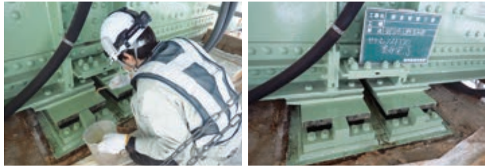
①【ゴム沓】 鋼桁、ゴム沓、沓モルタルなどをそのまま施工出来るため、塗装の取合いがなくゴム被覆の劣化対策にもなり、ゴム沓周りの補修に適している。
