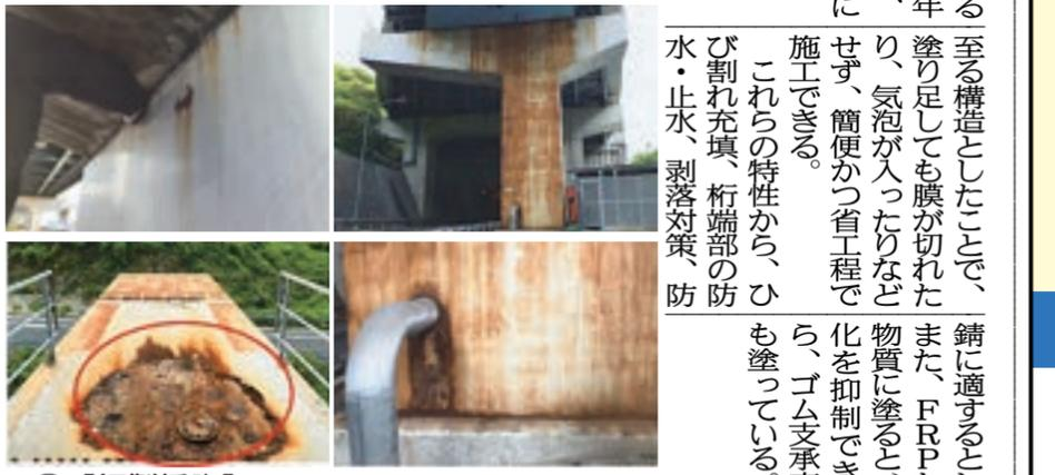
⑤【鋼製橋脚】橋脚など局所的に減肉した個所にて、パテにて成形後に防食対策として施工。排水周りなどの取合い部も一括で施工が可能。
