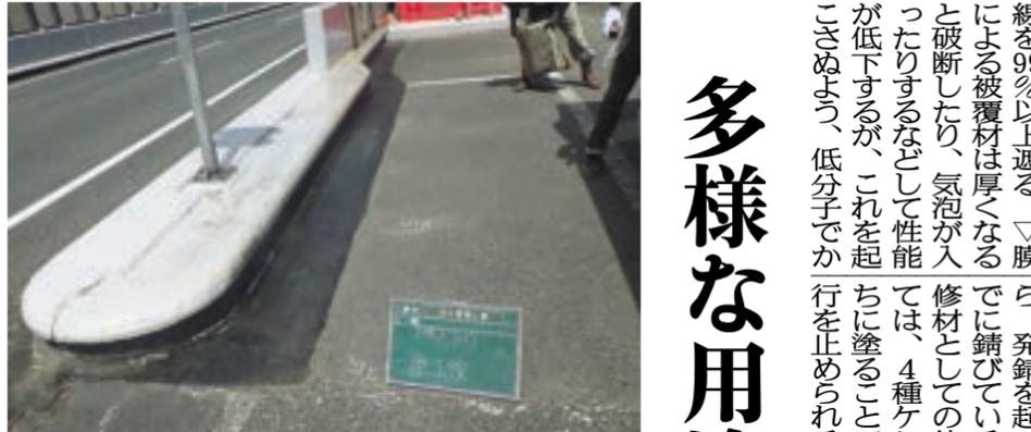
③【高欄・アイランドの取合い部】アイランド周りの止水対策として、縁石の取合い部分からガッター部まで施工。
